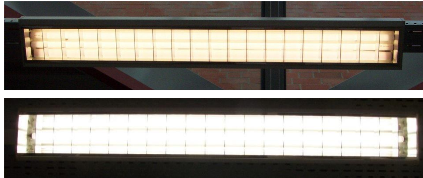
Zweiflämmige (oben) und einflämmige (unten) Raster-Leuchtstofflampenleuchte
