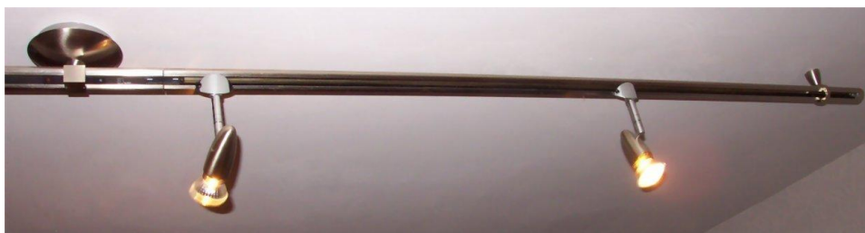
230-V-Schienensystem mit Strahlern für Halogenglühlampen mit Sockel GU 10
